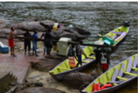
De korjaal wordt beladen met de vandiktebank, de betonmolen ligt er al in.
