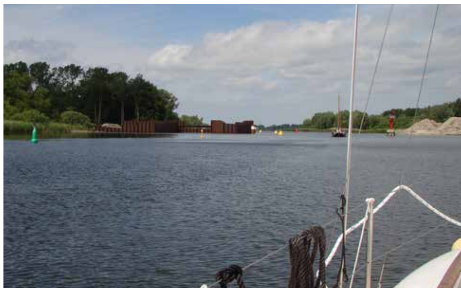
Nieuwe damwanden in het Drontermeer
