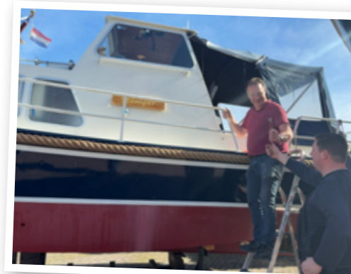
Stamper | Dick van Beek en Bastiaan van Hierden Aanbrengen Kabelaring (stootrand van touw) en antifouling
